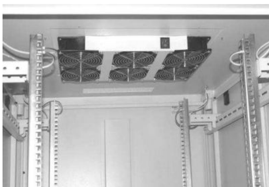
Установленный вентиляторный блок TLK-FAN6-GY в шкафу
