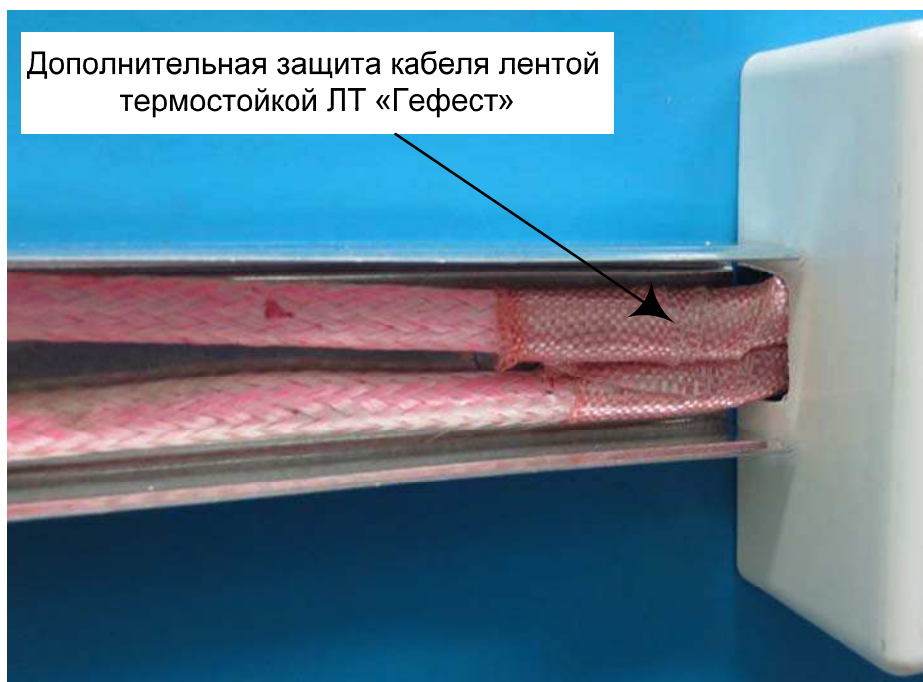
Рис. 22. Пример установки КМ-О с примыканием кабельного канала.
