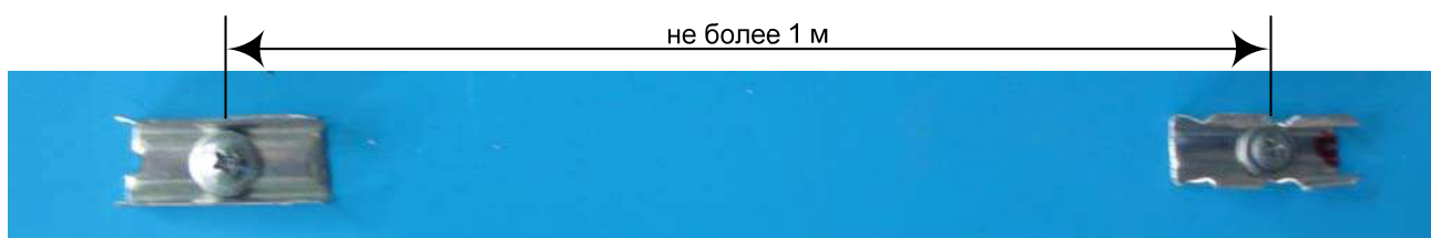
Рис. 20. Применение полупрофильного кабель-канала (верх).
