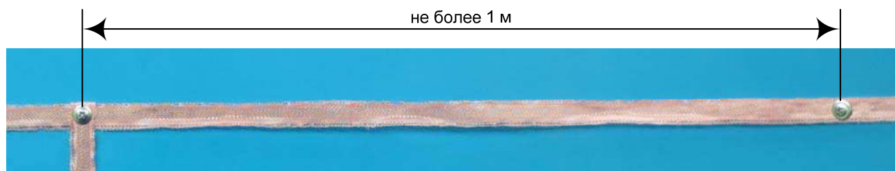
Рис. 13. Прокладка ленты основания.
