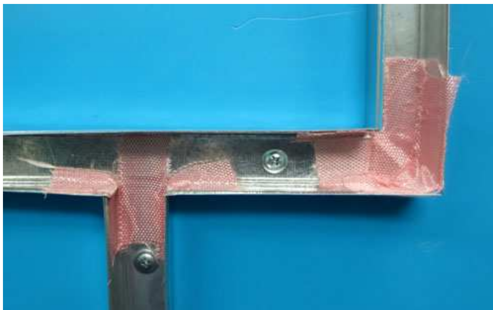
Рис. 17. Пример обработки резаных краев ККМО.
