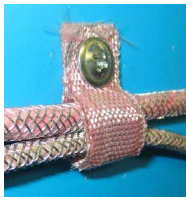
Рис. 5. Установка дюбель–хомута КФСТ.735322.041 и КФСТ.735322.164. Вариант 1.
