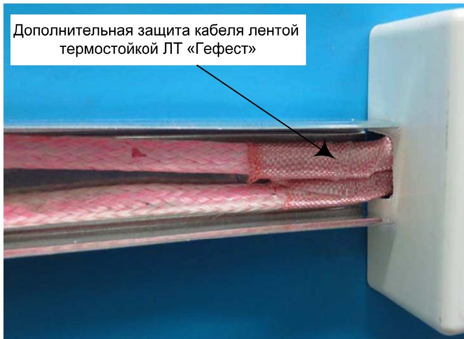
Рис. 22. Пример установки КМ-О с примыканием кабельного канала.
