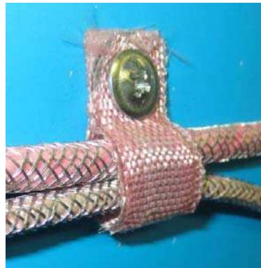
Рис. 5. Установка дюбель–хомута КФСТ.735322.041 и КФСТ.735322.164. Вариант 1.
