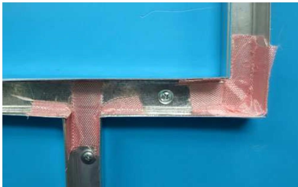
Рис. 17. Пример обработки резаных краев ККМО.
