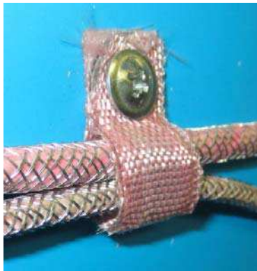
Рис. 5. Установка дюбель–хомута КФСТ.735322.041 и КФСТ.735322.164. Вариант 1.
