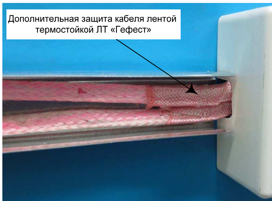
Рис. 22. Пример установки КМ–О с примыканием кабельного канала.
