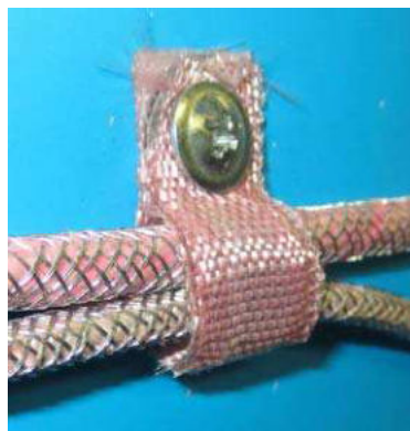
Рис. 5. Установка дюбель–хомута КФСТ.735322.041 и КФСТ.735322.164. Вариант 1.
