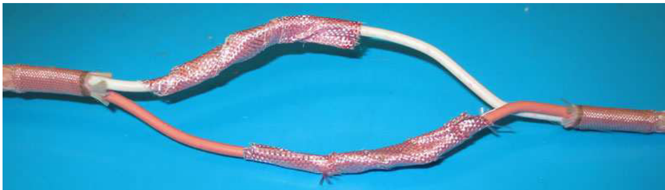
Рис. 28. Изоляция кабеля лентой термостойкой ЛТ «Гефест».
