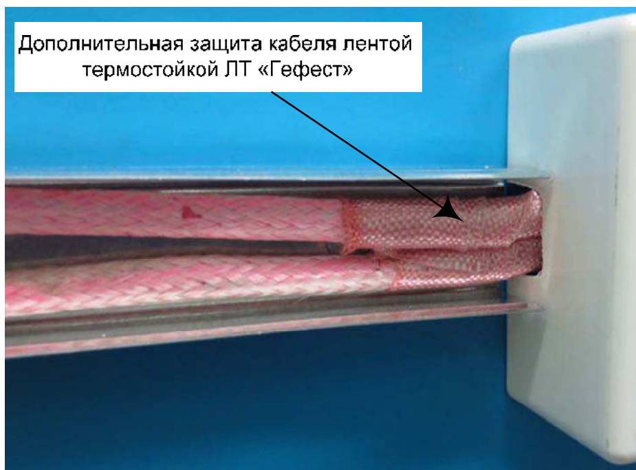
Рис. 22. Пример установки КМ-О с примыканием кабельного канала.
