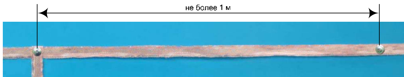
Рис. 13. Прокладка ленты основания.
